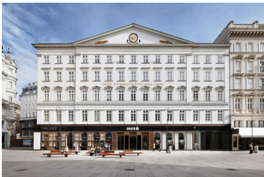
Historické sídlo Erste Group v letech 1838-2015, zdroj: Erste Group
